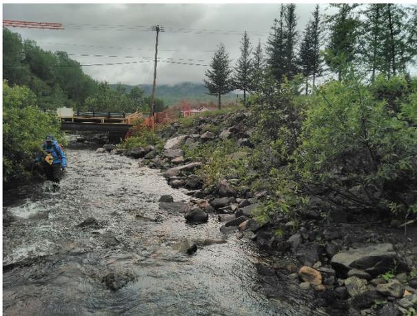
*Figure 16 : Photographie d'une zone avec enrochement, traverse de cours d'eau, couvert végétal et bande riveraine faible sur le ruisseau Patrice-Fortin - IQM segment 1.*
