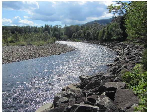
Figure 3 et 4 : Photographies d'une digue de protection contre l'érosion des berges de la rivière Saint-Jean-Saguenay - IQM - segment 2
