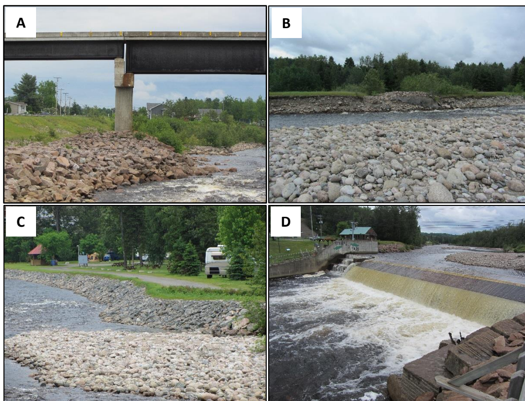
Figure 2.3 Exemples d’infrastructures présentes dans le lit mineur de la rivière à Mars : (A) pont ferroviaire stable dans l’UMD 1; (B) enrochement causant érosion très sévère dans l’UMD 2; (C) enrochement très faiblement en érosion dans la portion aval de l’UMD 2; (D) barrage Roméo-Tremblay stable à la transition des UMD 2 et 3.
