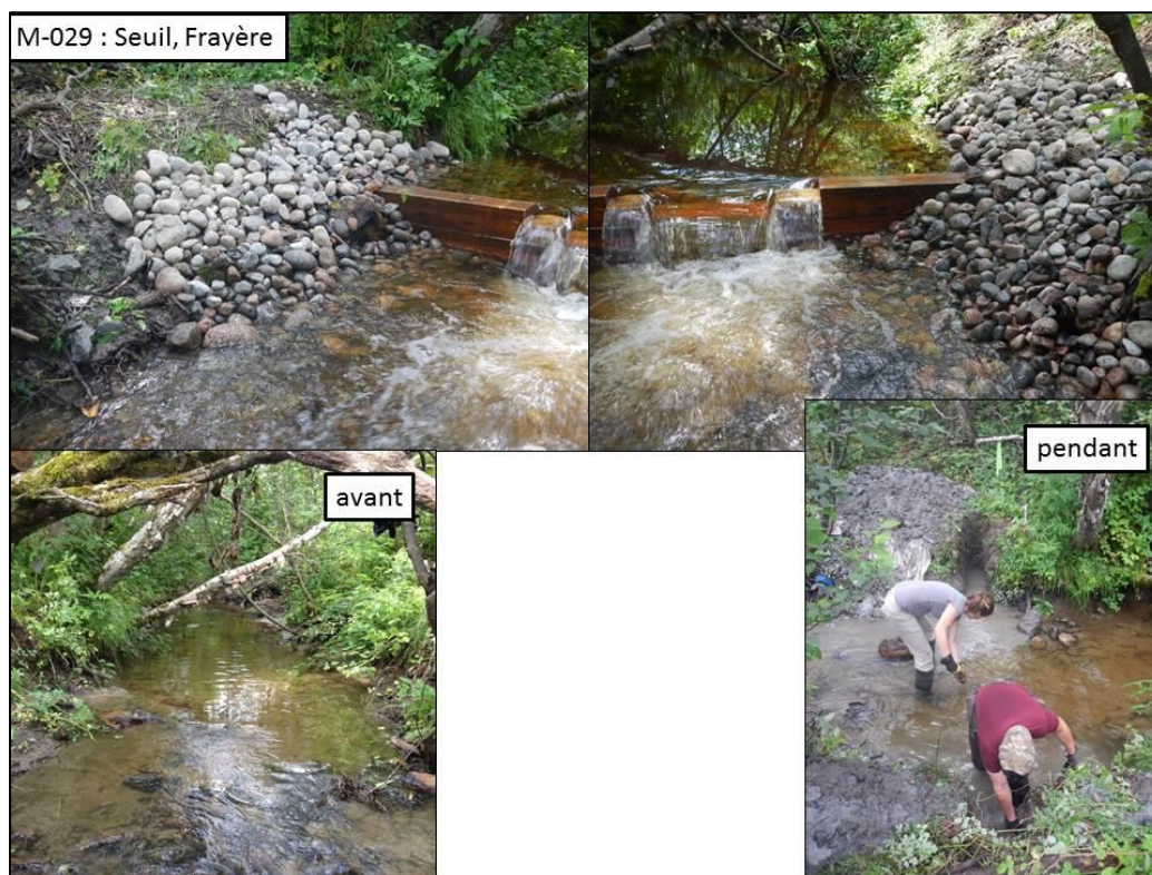
Figure 3. Aménagement du seuil et de la frayère M-029
