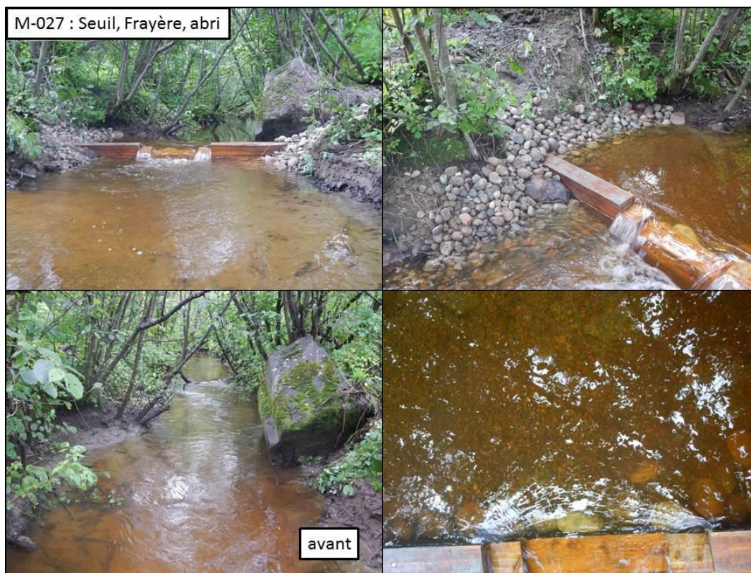
Figure 5. Aménagement du seuil et de la frayère M-027
