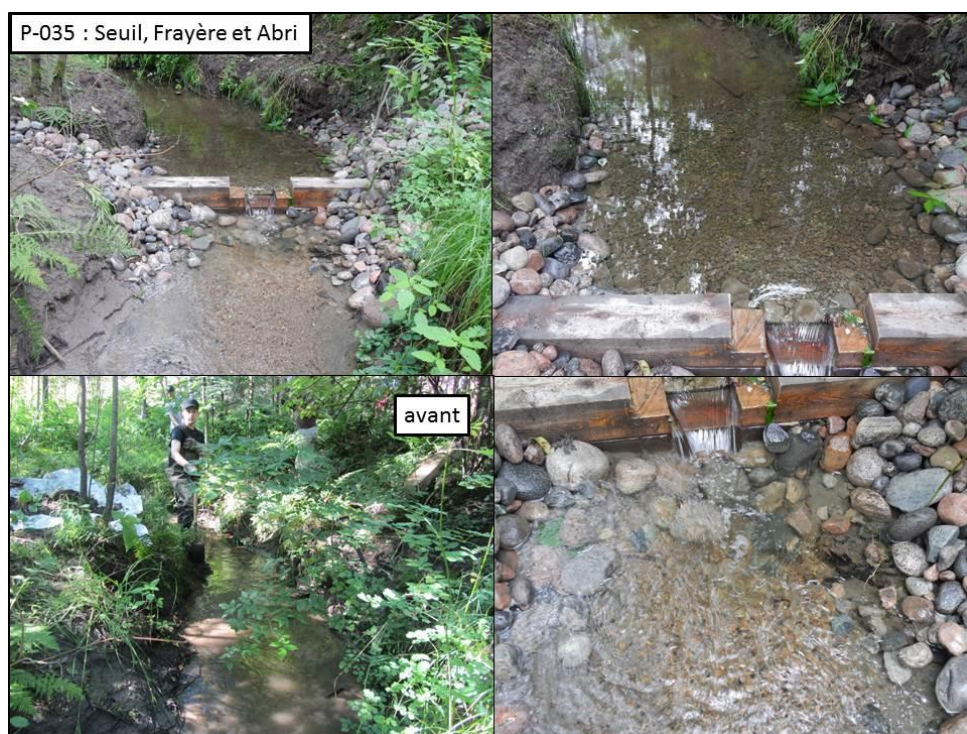
Figure 16. Aménagement du seuil et de la frayère P-035
