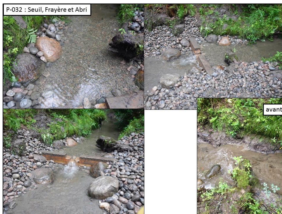
Figure 17. Aménagement du seuil, de la frayère et de l'abri P-032
