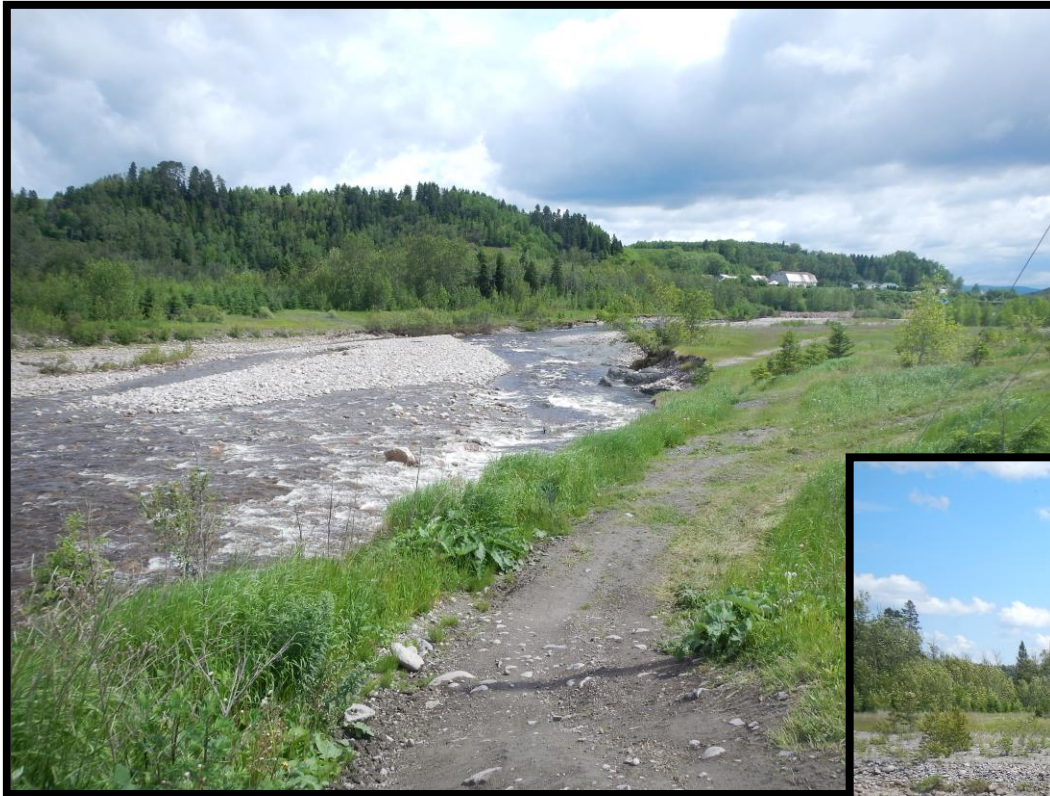
Photographie 5. Bande riveraine de faible qualité avec infrastructure sous forme de chemin de terre
